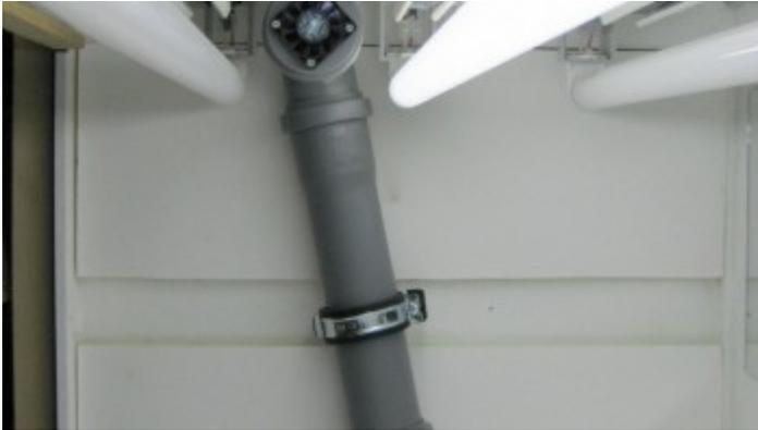
Rohr, 90°-Winkel, Rohrschelle und bereits bekannter HT-Endstopfen, diesmal gelocht, nebst flüsterleisem Mini-Lüfter:
