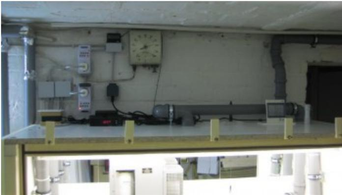
Es war ein Leichtes, den ohnehin im Heizungskeller vorhandenen Außenluftanschluss mit einem DN50 HT-Rohr anzuzapfen (langes graues Rohr über der Tür in Bild 006) und in der Mitte beider Ebenen enden zu lassen. In das HT-Rohr wurden bearbeitete Endstopfen eingeführt - über deren Tiefe im Rohr lässt sich die Frischluftmenge ganz passabel regulieren oder auch ganz stoppen:
