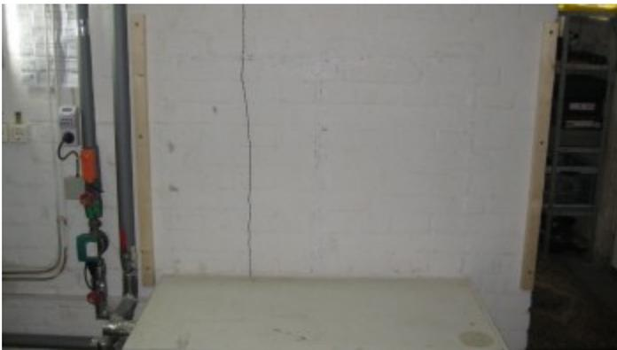
Es brauchte zunächst einen Seitenrahmen für die Station, zur Isolation mussten 5cm Styropor (gespachtelt) an die Wand.
